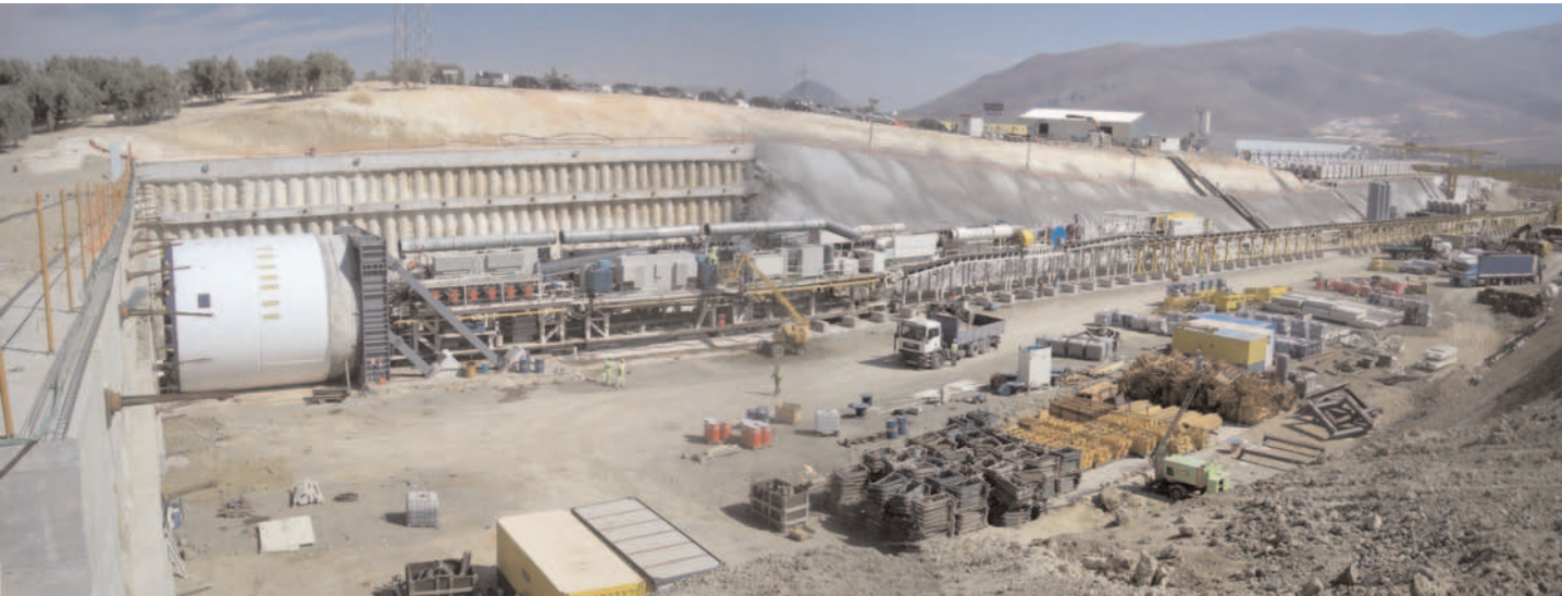
Fotografía 1. Vista general de la tuneladora EPB, con sus partes fundamentales: escudo y rueda de corte, el "back-up" y el tren/ Photograph 1. General view of the EPB TBM, with its main parts: shield and cutter head, the "back-up" and the train.
