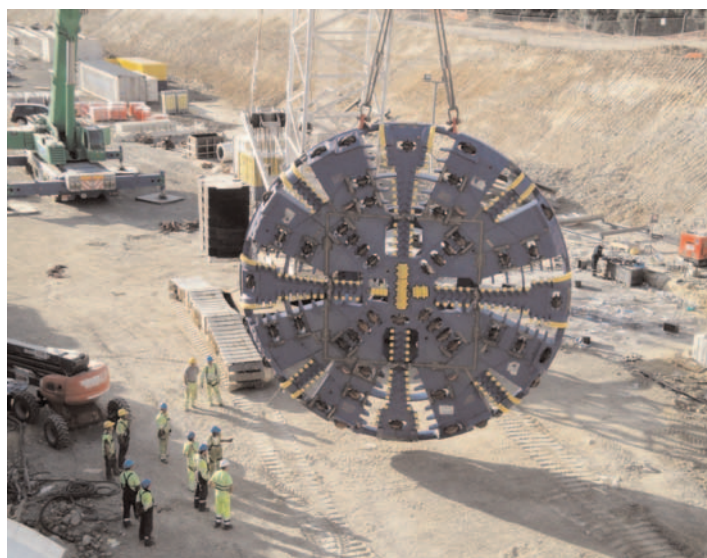
Fotografía 2. Vista de la cabeza de corte/Photograph 2.- View of the cutter head.
